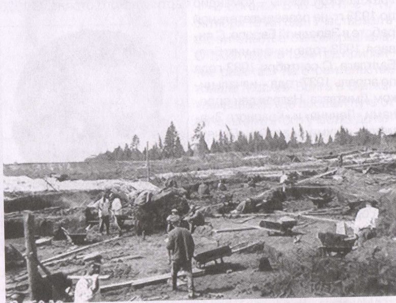
Начало работ в Волжском районе. Рытье котлована.
