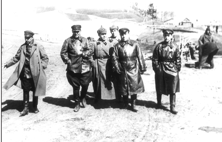
Сталин на строительстве
