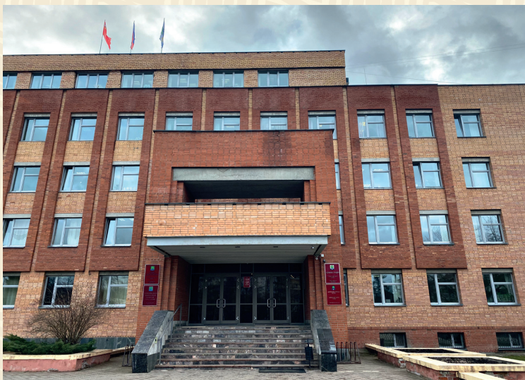
Здание администрации городского округа Дубна
