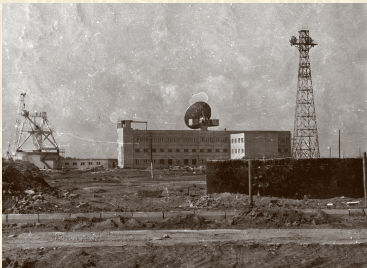
Строительная площадка ЦКС «Дубна», 1978 г.
