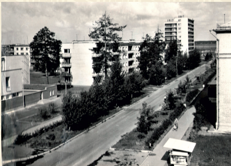
Строительство Ленинградской улицы в институтской части Дубны в 1957 году
