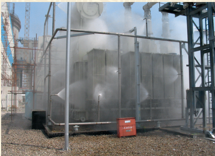
Испытания системы водяного пожаротушения Приборного завода «Тензор» на Тяньваньской АЭС (Китай) в 2004 г.
