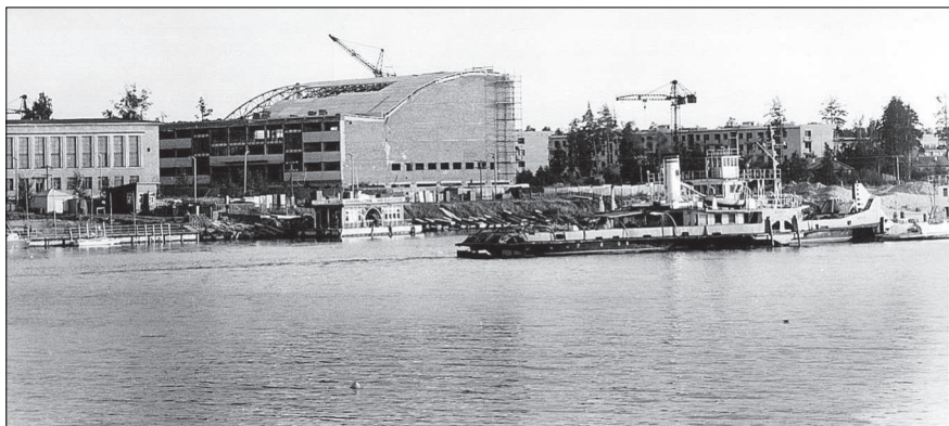
Бассейн «Архимед» строится
