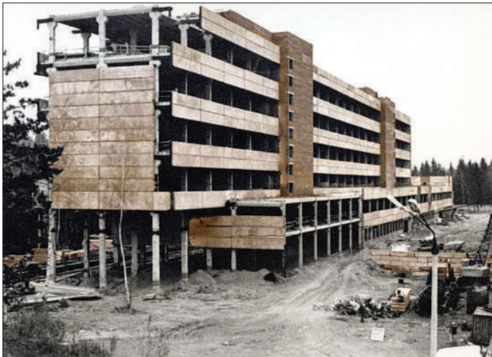
Строительство НИИ «Атолл»
