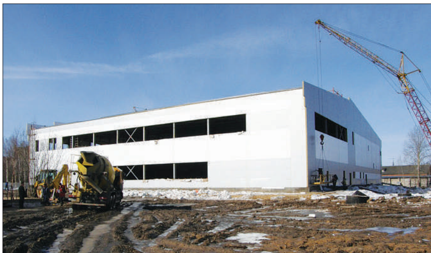
Строительство спорткомплекса «Олимп». 2013 г.
