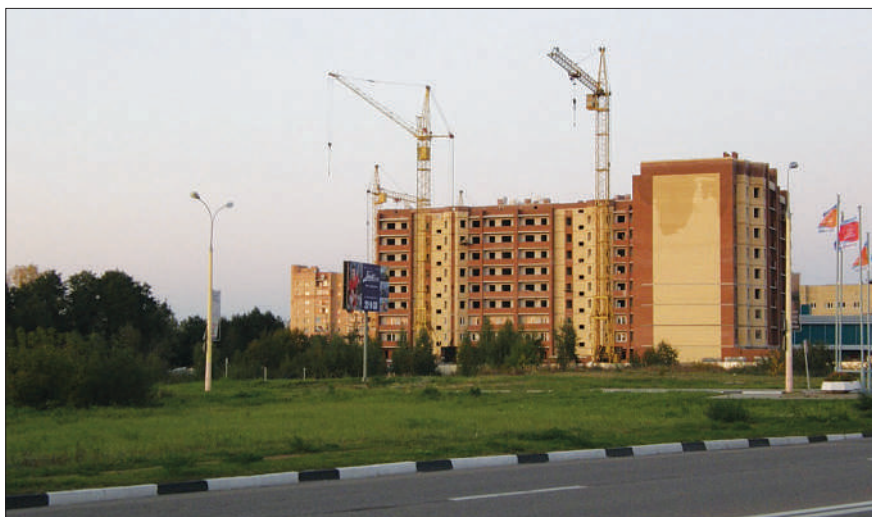
Строительство домов в 24-м квартале на Черной Речке
