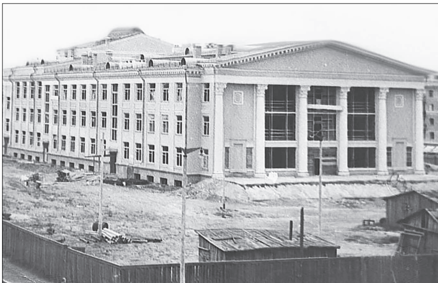
Строительство ДК «Октябрь»
