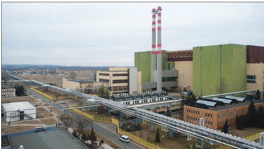
Энергоблоки АЭС «Пакш» (Венгрия), оснащенные системами внутри-реакторного контроля завода «Тензор»
