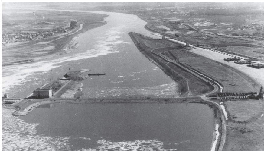
Панорама гидросооружений Волжского района
