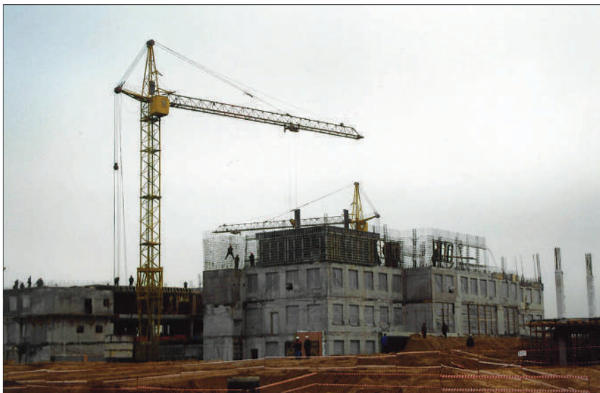
Начало строительства конгресс-центра в ОЭЗ «Дубна». 2007 г.
