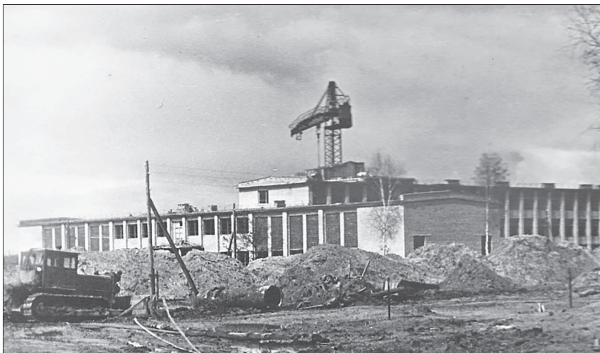
Школа № 8 строится. 1960 г.
