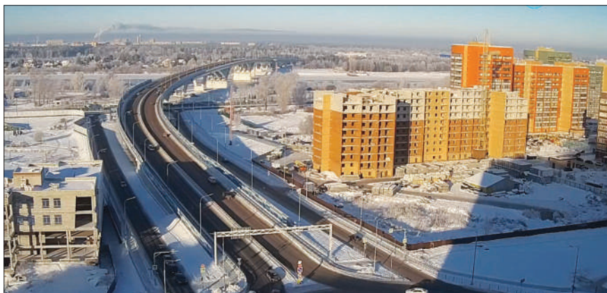
Строительство моста. 2017 г.
