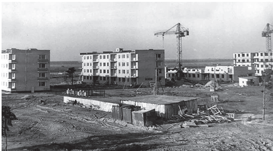
Строительство болгарских домов на ул. Парковой (ныне ул. Векслера)
