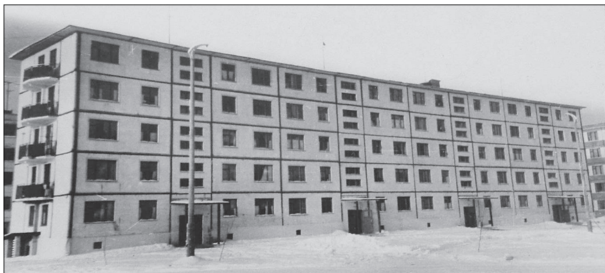
Один из первых домов крупнопанельного домостроения. 1964 г.
