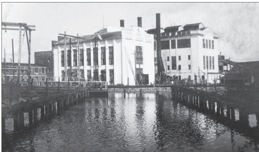
ТЭЦ Большой Волги
